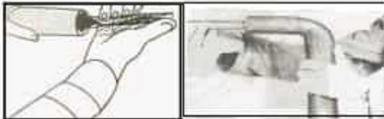
شكل (٤ - ١٦) عملية دفع أنبوية الأرماتليكس فوق الأنابيب
