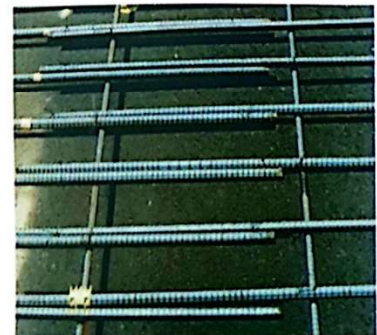
الصورة ٧٢: وصلات شيش عن طريق تكديسهم و ربطهم بسلك ناعم
