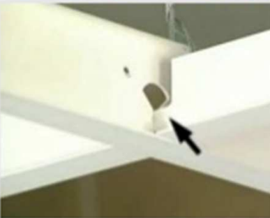
يوجد بأسفل كل سلك فتحة تستخدم في ربط الكمرات الثانوية بالريسيه
