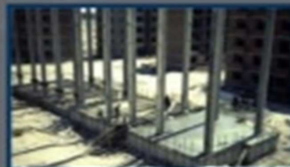
توضيح لطريقة تثبيت الأعمدة في تجاويف البلاطات
