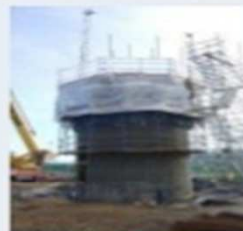
المبنى اثناء البناء
