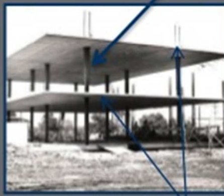
مراحل إنشاء الحرم بالبلاطات المرفوعة
