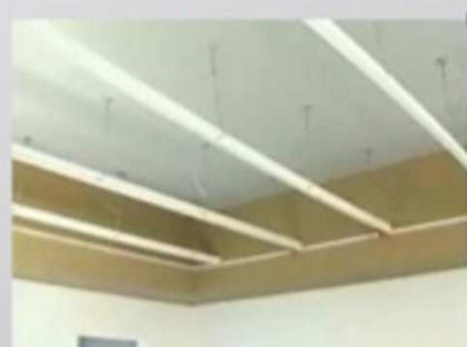
شكل السقف بعد تركيب الشرائط الطولية للزاوية حرف T
