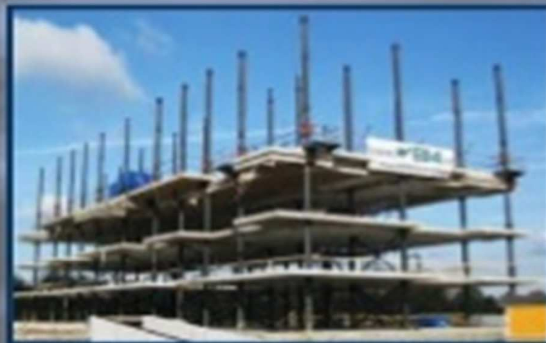
نظام البلاطات المرفوعة أثناء التنفيذ و رفع البلاطات
