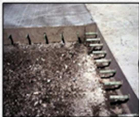
مفاصل الانشاء بين عمليات الصب المنفصلة
