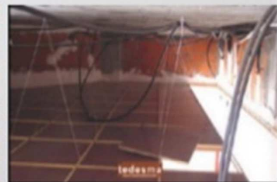
شكل التوصيلات فوق السقف الخشبي
