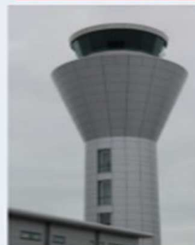
المبنى بعد البناء
