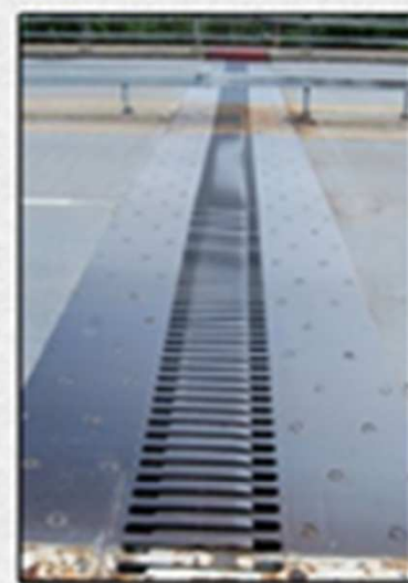
المفاصل التمددية السماح بالتمدد الحراري للعناصر الانشائية
