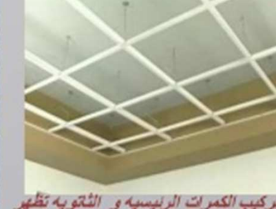
بعد تركيب الكمرات الرئيسيه و الثانويه تظهر بهذا الشكل و يتم تركيب خدمات الاضاءة و
