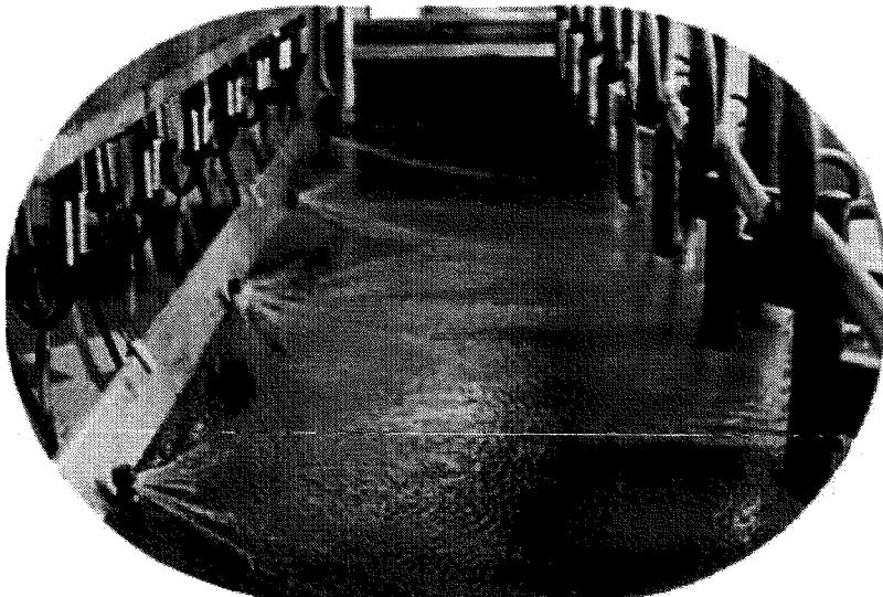
نظام غسيل حجرة الحليب يساعد على إنتاج الحليب الجيد
