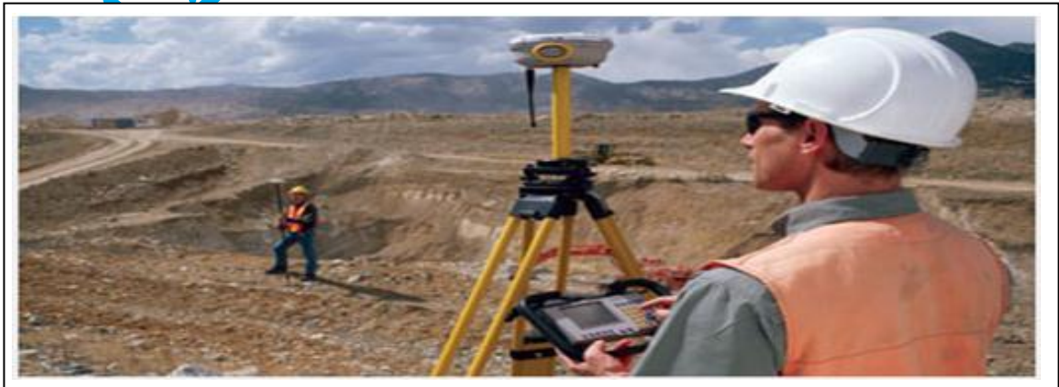
الشكل (29) استخدام جهاز المحطة المتكاملة مع جهاز (GPS) في الأعمال المساحية
