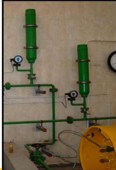
تستخدم لمواجهة تمدد الكلور السائل عند ارتفاع درجة الحرارة و تثبيت في خط الكلور السائل او عند المبخر
